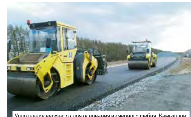
Уплотнение верхнего слоя основания из черного щебня, Камышлов.
